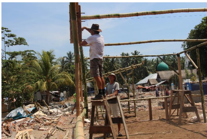
Vi hjälper till att bygga en tillfällig förskola på Lombok.
